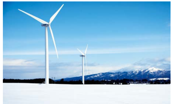
日本風力開発(株)の設備
