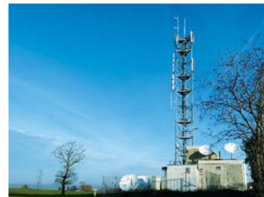
通信用タワー
