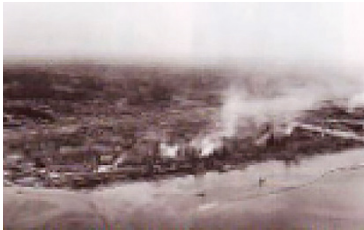
川崎製鉄(株)(現 JFEスチール(株)): 千葉製鉄所建設(千葉県) 戦後初の高炉建設による鉄工業の近代化
