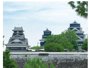
被災した熊本城(二の丸駐車場より)
