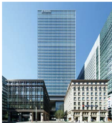
京橋エドグラン外観
