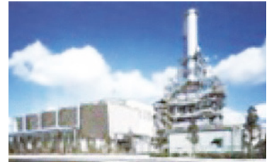
中山共同発電(株):IPP発電事業(大阪府) 規制緩和にともなう鉄鋼メーカーの電力事業進出 を本邦初のプロジェクトファイナンスで支援
