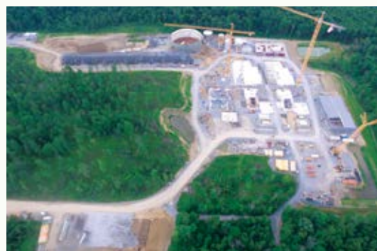
建設中の発電所
