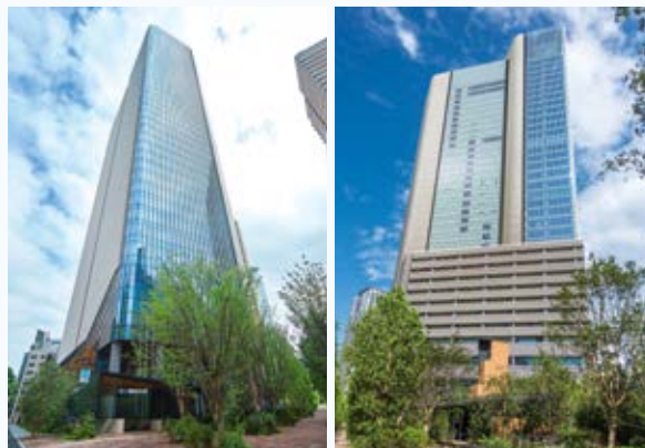
赤坂インターシティAIR 外観
