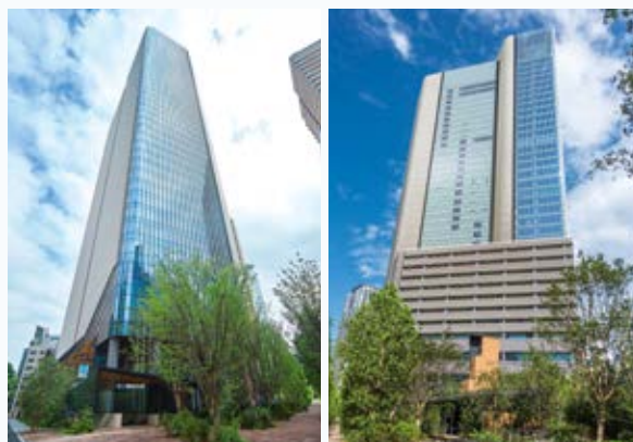
赤坂インターシティAIR 外観
