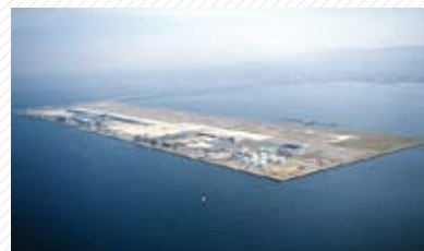
関西国際空港(株):関西国際空港 大規模国際ハブ空港の建設
