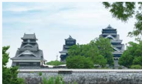
被災した熊本城(二の丸駐車場より)
