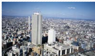
(株)新都市開発センター(現(株)サンシャインシティ): サンシャインシティ建設(東京都) 池袋の再開発による新都市形成
