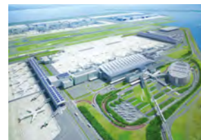
東京国際空港ターミナル
