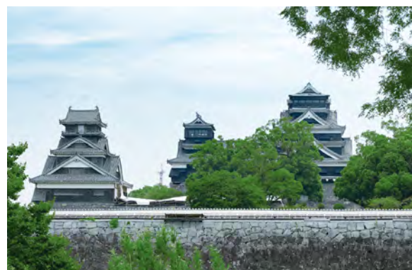
被災した熊本城(二の丸駐車場より)
