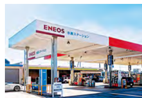
日本水素ステーションネットワーク
