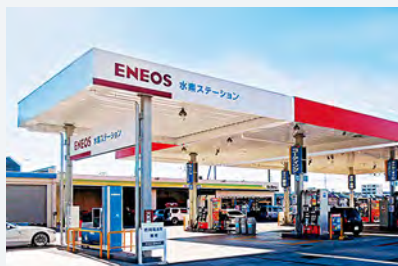
日本水素ステーションネットワーク合同会社 (JHyM) : 水素社会実現に向けた金融力を通じた支援 写真提供: JXTGエネルギー (株)
