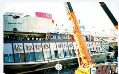
阪急電鉄(株)： 震災復旧工事(兵庫県) 震災により破壊された交通インフラの復旧工事
