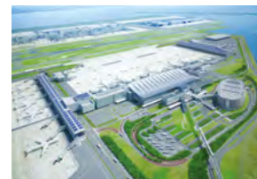
東京国際空港ターミナル
