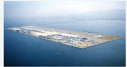
関西国際空港(株)： 関西国際空港 大規模国際ハブ空港の建設
