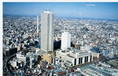
(株)新都市開発センター(現(株)サンシャインシティ)： サンシャインシティ建設(東京都) 池袋の再開発による新都市形成
