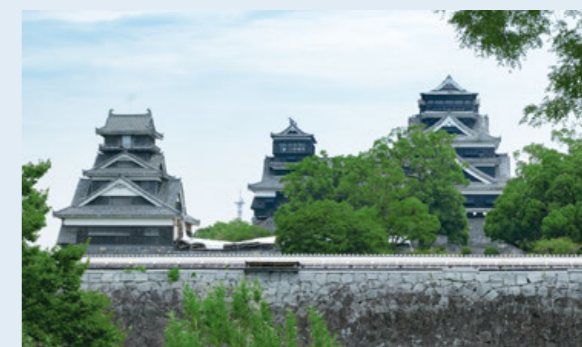
被災した熊本城(二の丸駐車場より)
