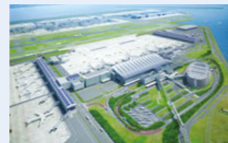
東京国際空港ターミナル
