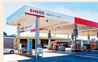
日本水素ステーションネットワーク
