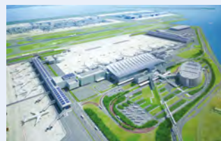
東京国際空港ターミナル
