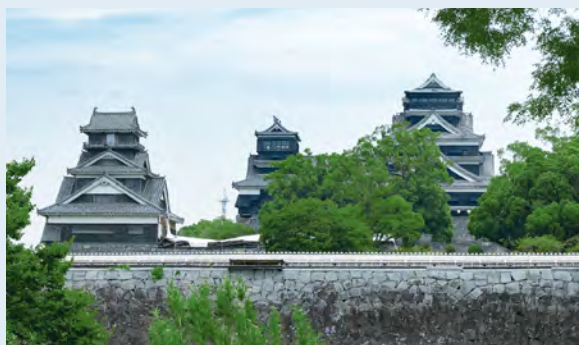
被災した熊本城(二の丸駐車場より)
