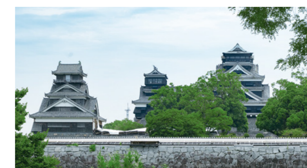
被災した熊本城(二の丸駐車場より)
