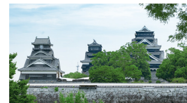
被災した熊本城(二の丸駐車場より)
