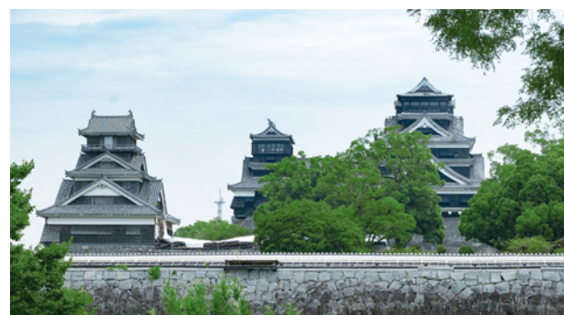
被災した熊本城(二の丸駐車場より)
