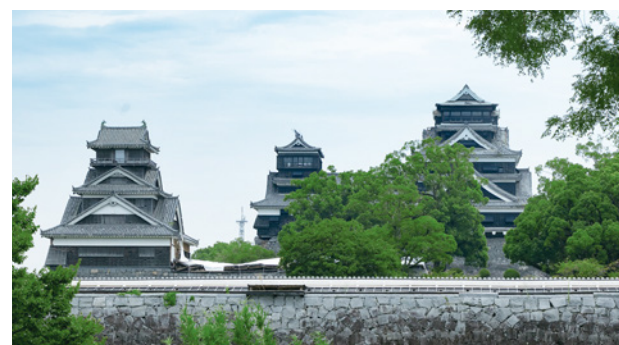
被災した熊本城(二の丸駐車場より)
