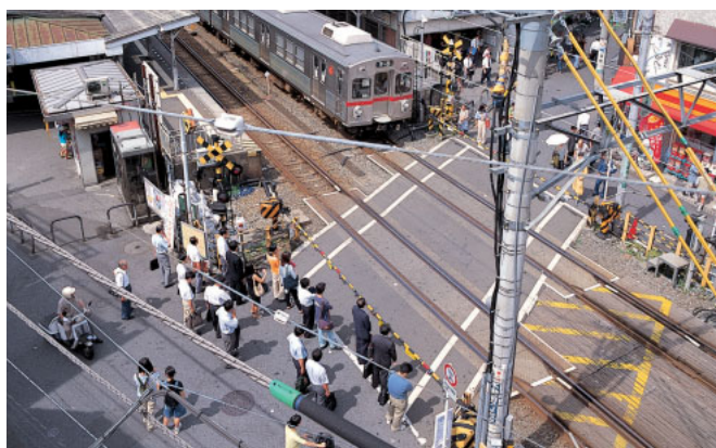
立体交差化前の状況
