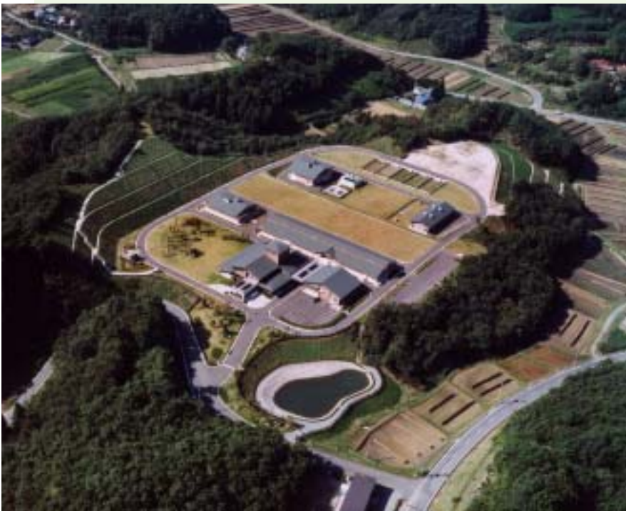
福島県三春町の三春浄水場全景 写真提供:三春町企業局
