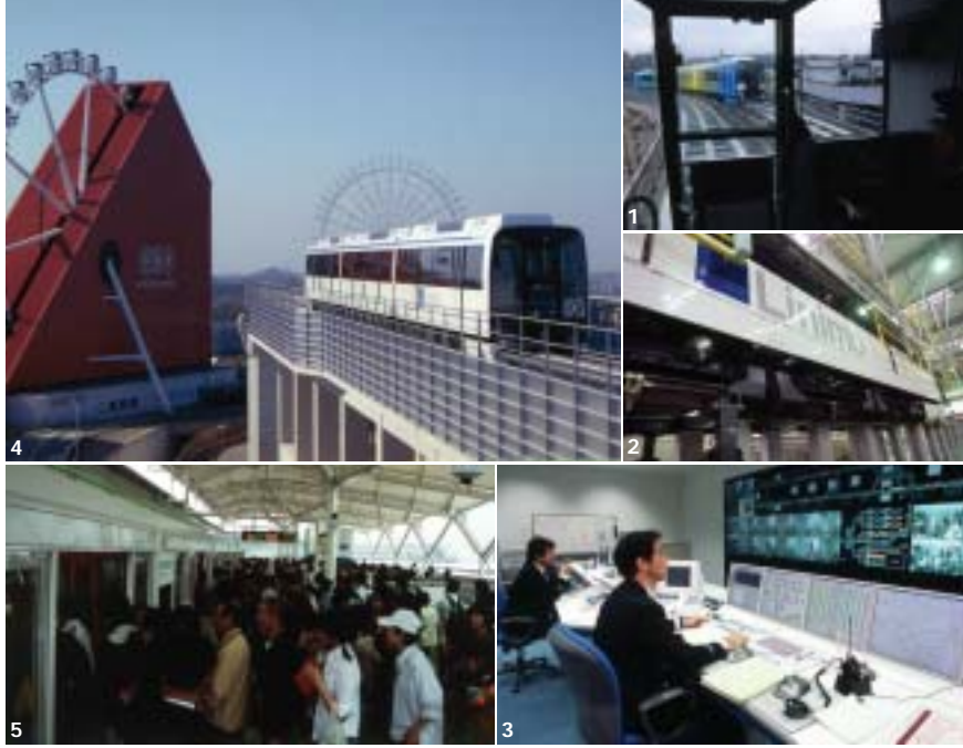
1リニモは無人運転で走行するが、万博期間中は添乗員を1人乗せている。2磁力で浮上して走行するリニモ。浮上しているのはわずか6ミリ。それでも走行路の接触・転動がないため、走行が静かで、騒音・振動が小さい。3すべての車両の管理は集中管理センターのモニターによって管理されている。4「リニモは万博のパビリオンですか?」という質問がでると、万博の風景になじんで走行するリニモ。5万博期間中は、土日休日を中心に、ホームには常に人が溢れている状態。ホーム入場前から下車後まで、係員が常に常駐し、お客さまがスムーズに流れていけるよう、最善の努力を払っている。
