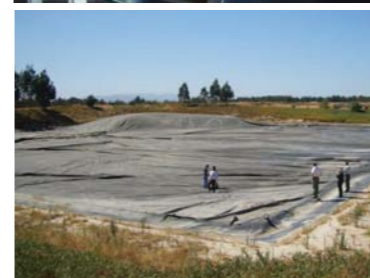
東京電力案件(チリメタン回収・200万トン) 左:発酵槽加熱用のボイラー施設。右:養豚場の閉鎖式発酵槽。下:メタンガスのフレアリング設備。
