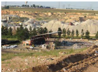
ゴミ埋立処分場ガス発電・100万トン (南アフリカ・ESWM社)
