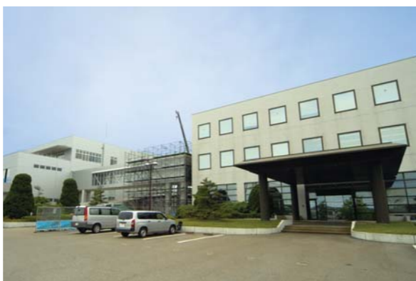
写真左側の建物が今回の制度融資で建設中の新工場。
