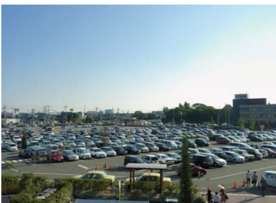
紀の川にほど近い場所に位置する大型ショッピングセンター「メッサオークワガーデンパーク和歌山店」は、防災活動拠点として提供される。ヘリコプターが離着陸できるように、駐車場には高い構造物を作らないように設計されている。
