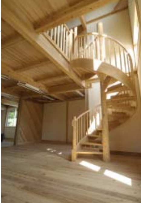
評価が高まる一方の『スモークウッドキオク君』で作られたモデルハウス。すべて「キオク君」を使用したモデルハウス内のらせん階段(上)ベランダ(中)床(下)反り・割れの少ない「キオク君」を使うことで、らせん階段もできるようになった。とくに、この5月の商品発表会以降、大手の建材メーカーやハウスメーカーからの引き合いが急増しているという。
