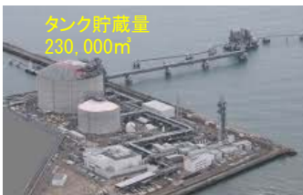
図表1-3 日立LNG基地
